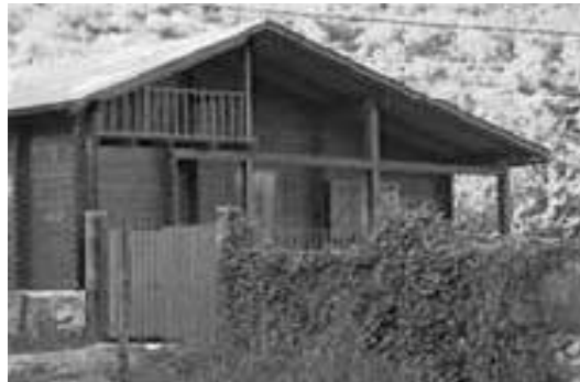
Fotografía 2-4. Edificación construida en madera
