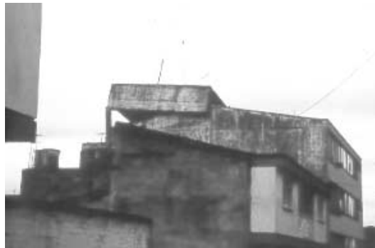
Fotografía 2-16. Daños severos en tanques
