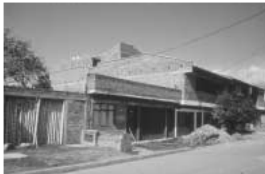
Fotografía 2-2. Edificación construida en mampostería
