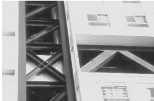
Fotografía 2-3. Edificación construida en acero
