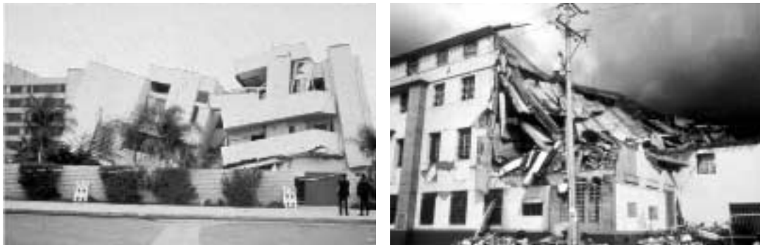
Fotografías 2-6. Colapso total y parcial de edificaciones
