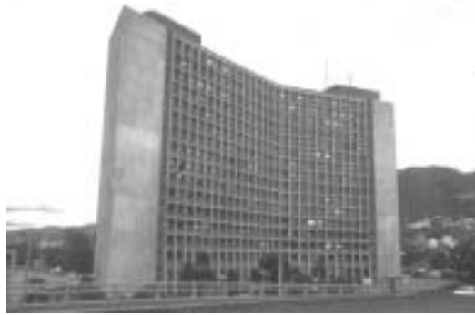
Fotografía 2-1. Edificación construida en concreto reforzado con muros estructurales
