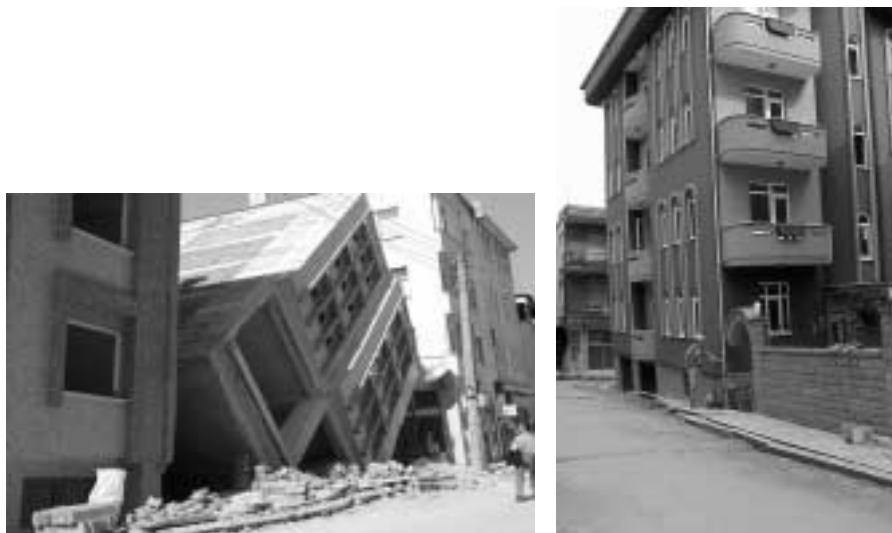
Fotografías 2-8. Fallas en el suelo de cimentación
