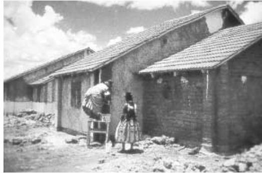
Fotografía 2-5. Edificación construida en tapia o adobe
