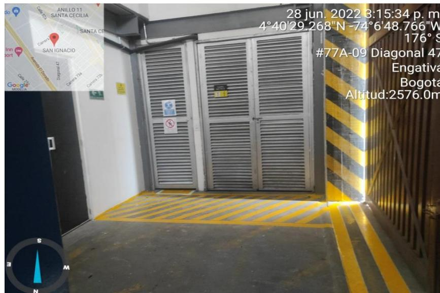
En pasillo o hall de acceso que conecta la entrada trasera de la Bodega 11 con el cuarto RESPEL, se realizaron las siguientes adecuaciones: se pintó de blanco en su totalidad las paredes, se instaló luminaria de tipo LED, se despejó totalmente para que se permitiera el paso, se instaló la señalización de salidas de emergencia con en constante iluminación, se instaló señalización de prohibido
