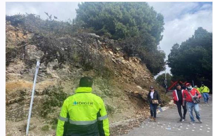
Recolección de escombros
