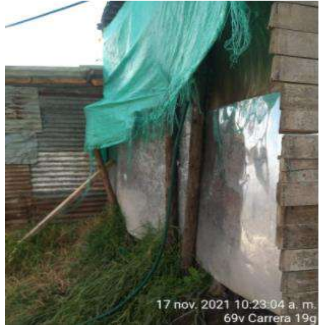
Fuga de agua mangueras provisionales asentamientos informales ubicados costado nororiente de la pizona 2
