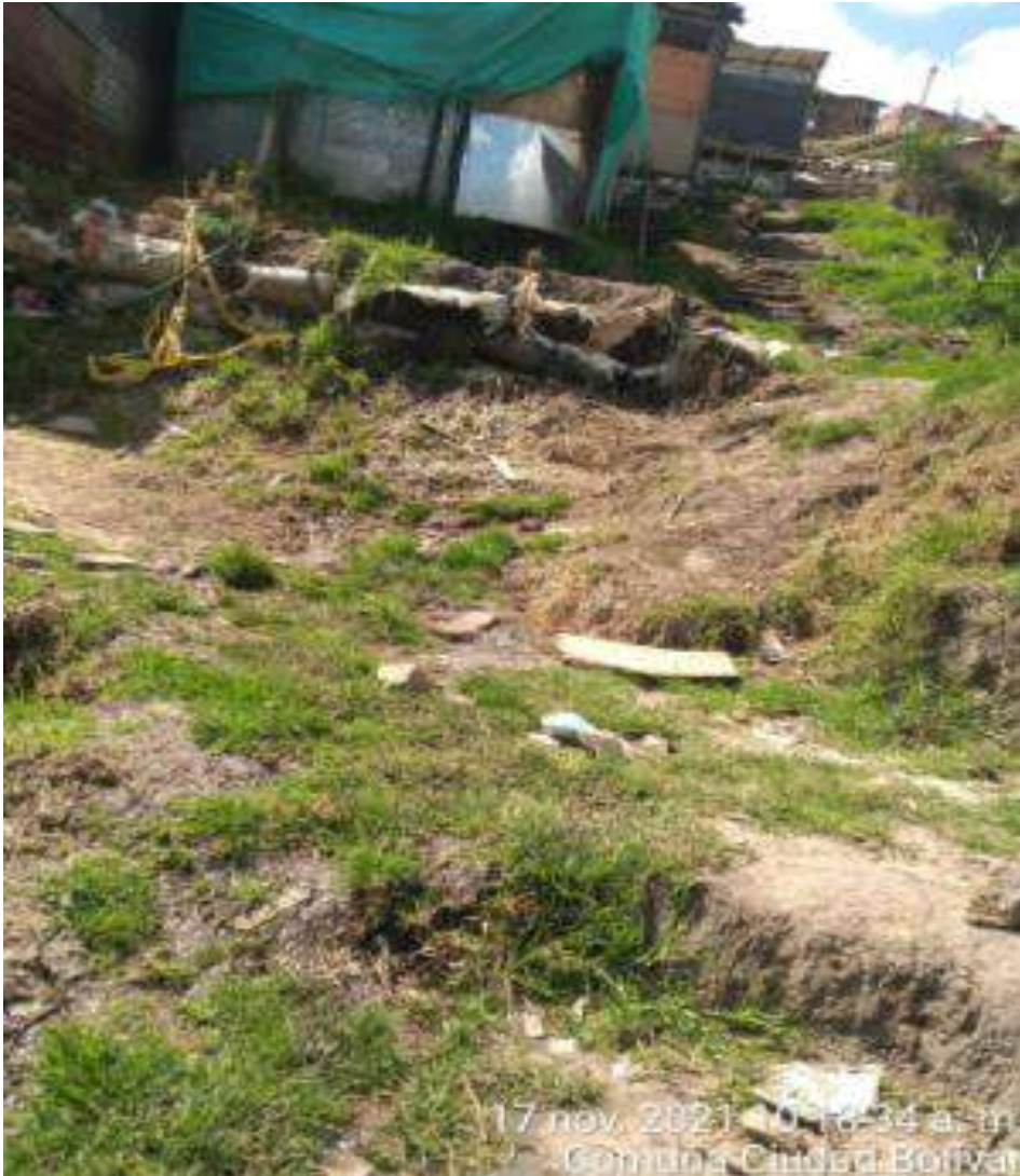
Conectada una manguera provisional, en la cual hay fuga de agua permanente hacía el terreno, costado nororiente de la pizona 22
