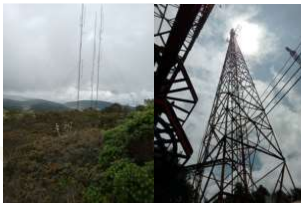
Mantenimiento preventivo estaciones de telecomunicaciones Suba y el cable - Agosto 2021
