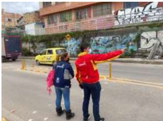
Recorrido en compañía de la Alcaldía local de Suba para revisar afectaciones y recomendaciones dadas por el Diagnóstico técnico emitido por el IDIGER sobre la estabilidad estructural.
