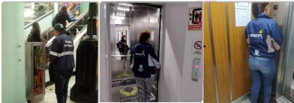
Verificación escaleras eléctricas y ascensores 2021
