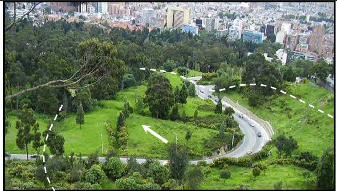
Fotografía No. 1. Panorámica del área inestable, las líneas punteadas indican los flancos del deslizamiento y la flecha la dirección del movimiento. En el talud superior de la vía se observan señales de inestabilidad, nótese las ondulaciones del terreno y algunos escarpes suavizados.
