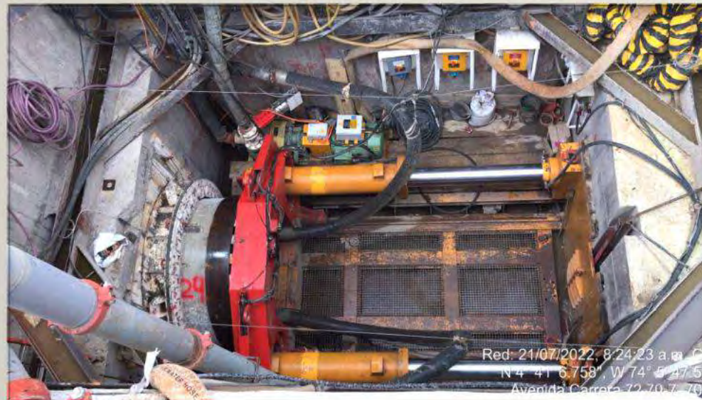
HINCADO DE TUBERÍA
