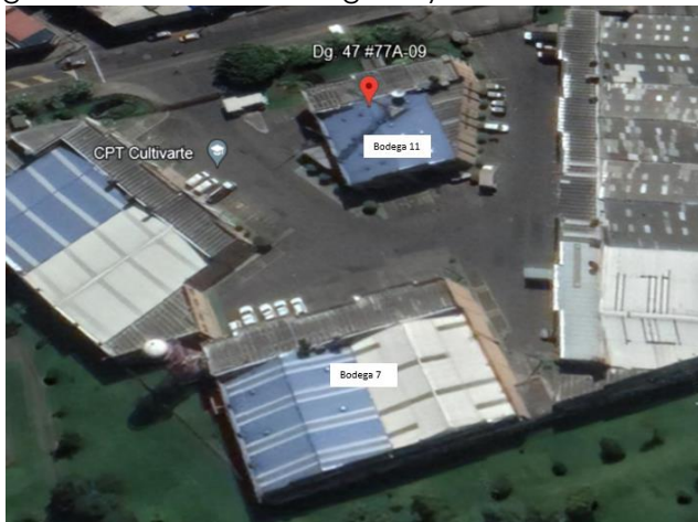
Figura 53 Cubiertas bodegas 7 y 11 Sede Normandía
