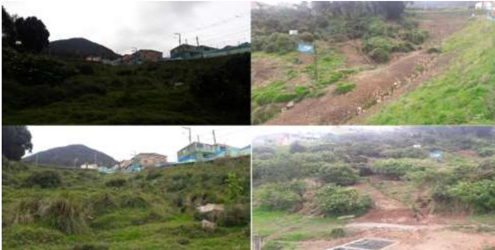
**Imagen 11. Obras de mitigación de riesgos - (Técnicas de bioingeniería para el manejo de aguas superficiales y subsuperficiales)- Antes y después del contrato 318 de 2017**
