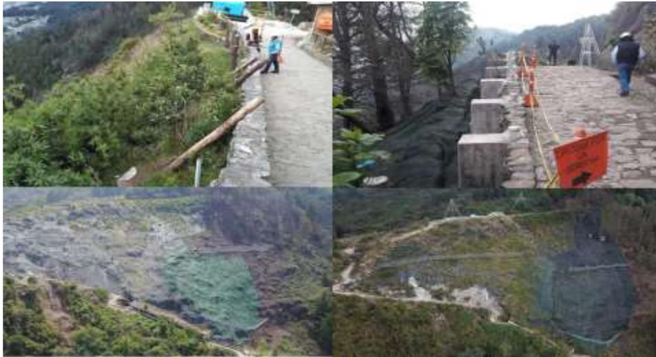
**Imagen 10. Obras de mitigación de riesgos - (Estabilización del talud) antes y después del contrato 321 de 2017.**
