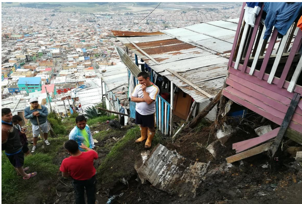
Foto No. 1 y 2 – Evento SIRE 5190476 – Riesgo de Colapso Estructural, Localidad de Ciudad Bolívar – La concepción, 28 de Octubre de 2018
