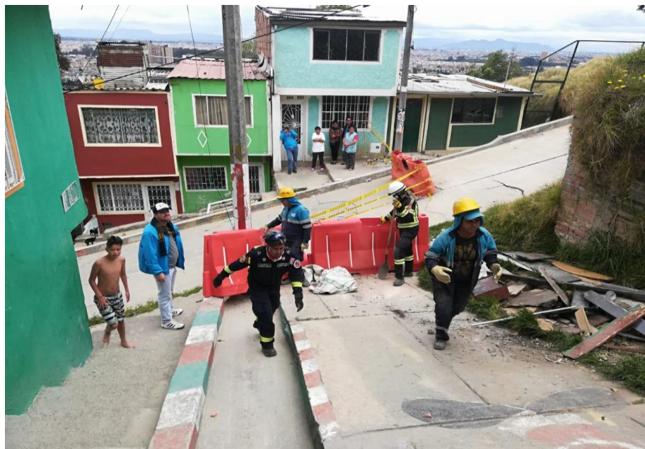
Foto No. 1 y 2 – Evento SIRE 4983773– Riesgo de Colapso Estructural, Localidad de Ciudad Bolívar – Peñón del Cortijo, 23 Septiembre de 2018
