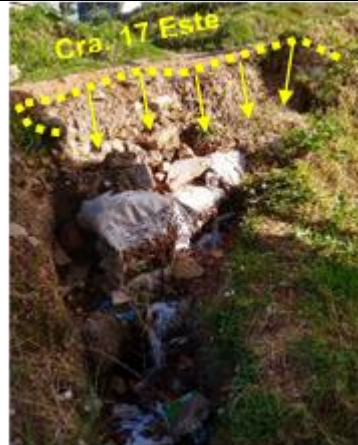
Fotografía 4 y 5. Evento Sire No. 5237274. Desprendimiento de material de relleno en el predio de la Carrera 17 Este N° 81ª -05 sur. (Fotografía tomada el 13 de Diciembre de 2018)
