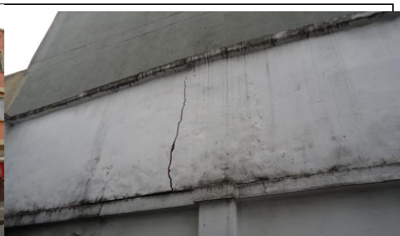
Fotografía 6 y 7. DI-12520. Afectación en muro de cerramiento del predio de la Calle 66 N° 68 F-25, en el barrio la Estrada de la Localidad de Engativá. (Fotografía tomada el día 15 de diciembre de 2018)
