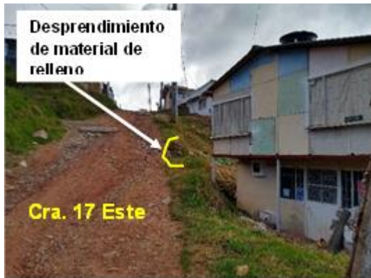
Fotografía 4 y 5. Evento Sire No. 5237274. Desprendimiento de material de relleno en el predio de la Carrera 17 Este N° 81ª -05 sur. (Fotografía tomada el 13 de Diciembre de 2018)
