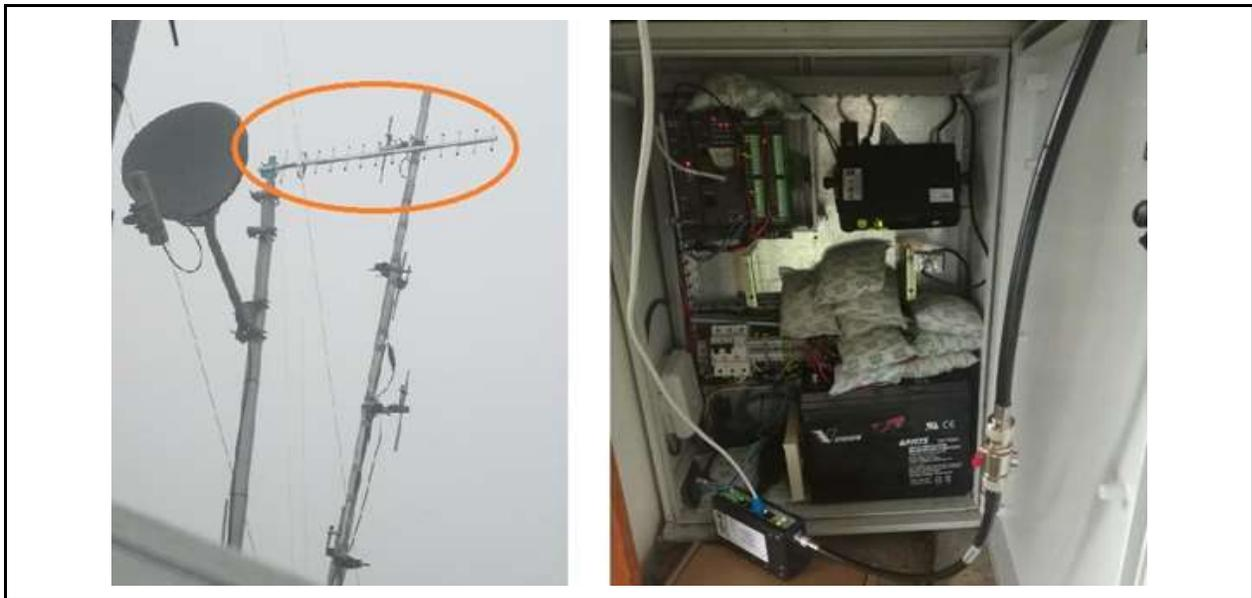
*Guadalupe: Se instaló y configuró un radio cnReach N500 el cual se ubicó en un gabinete disponible para este fin en el cerro; la antena se ubicó en un mástil existente de aproximadamente 3 metros de altura, se colocan los elementos necesarios para su funcionamiento como cable coaxial, protector de red, conectores, terminales y otros.*
