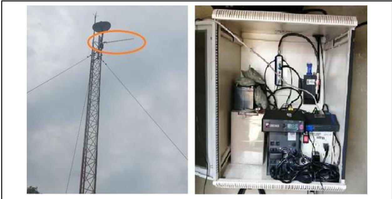
*Parque Timiza: Se instaló y configuró un radio cnReach N500 el cual se ubicó en un gabinete disponible en la caseta de la estación sismológica; la antena se ubicó en una torre existente de aproximadamente 12 metros de altura, se colocan los elementos necesarios para su funcionamiento como cable coaxial, protector de red, conectores, terminales y otros.*
