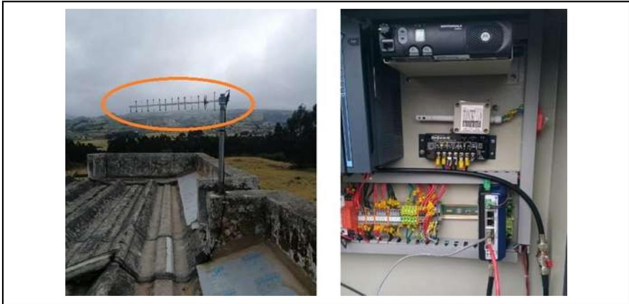
*UAN Usme: Se instaló y configuró un radio cnReach N500 el cual se ubicó en un gabinete disponible en el techo de una edificación de la institución; la antena también se ubicó en la parte superior de la edificación en un mástil instalado previamente de aproximadamente 1,2 metros de altura, se colocan los elementos necesarios para su funcionamiento como cable coaxial, protector de red, conectores, terminales y otros.*
