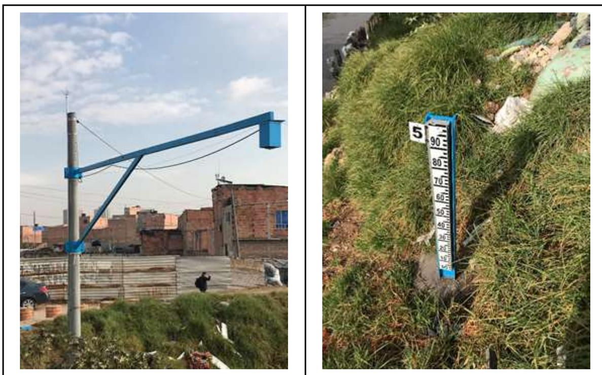
*Estructuras para el soporte de los sensores de nivel de las estaciones hidrológicas cuenca del río Tunjuelo. Foto de la izquierda vista general del soporte del sensor, poste y Brazo, foto de la derecha se muestra la sección de miras tramo 3 de la estación Independencia en la localidad de Bosa. Toma del 14-02-2020*
