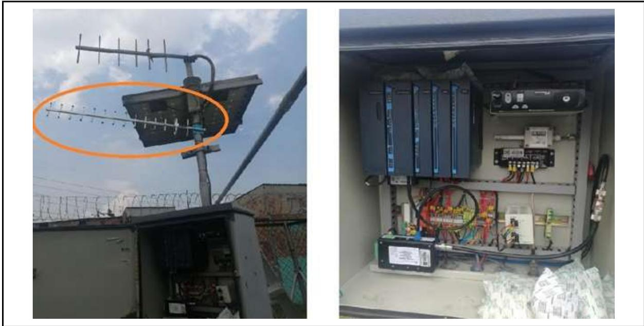
**San Benito EAAB:** Se instaló y configuró un radio cnReach N500 el cual se ubicó en un gabinete disponible para este fin en la planta; la antena se ubicó en un mástil existente de aproximadamente 3 metros de altura, se colocan los elementos necesarios para su funcionamiento como cable coaxial, protector de red, conectores, terminales y otros.
