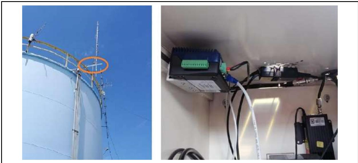
*Quiba: Se instaló y configuró un radio cnReach N500 el cual se ubicó en un gabinete disponible en el cuarto de bombas del acueducto; la antena se ubicó en la parte superior de un tanque de agua de la planta de aproximadamente 12 metros de altura, se colocan los elementos necesarios para su funcionamiento como cable coaxial, protector de red, conectores, terminales y otros.*
