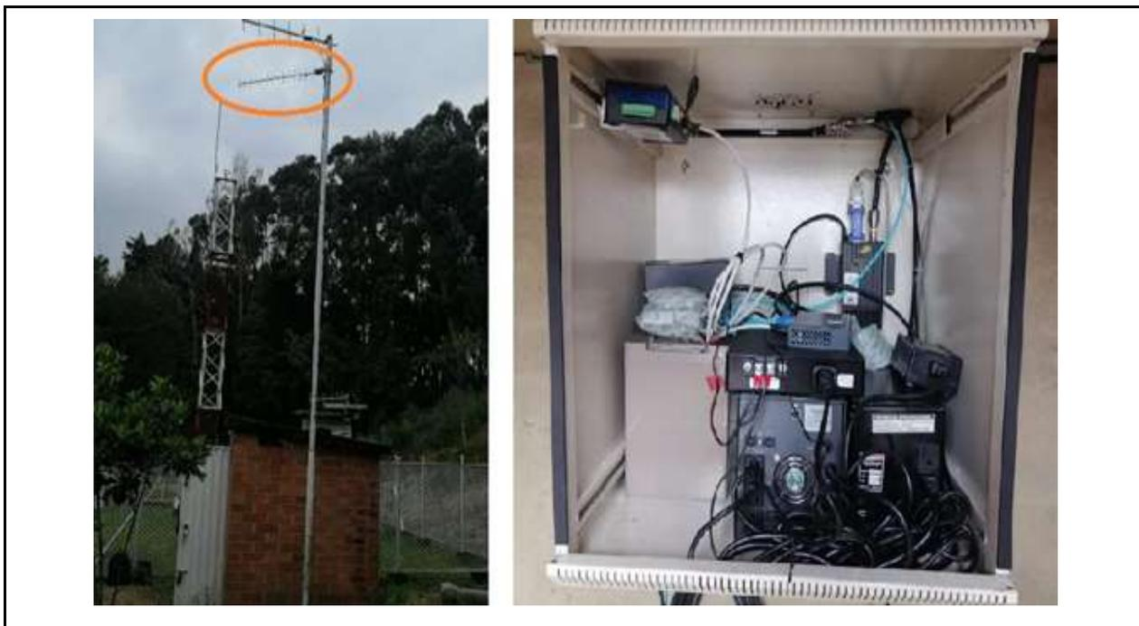
*Vitelma: Se instaló y configuró un radio cnReach N500 el cual se ubicó en un gabinete disponible en la caseta de la estación sismológica; la antena se ubicó en un mástil existente de aproximadamente 6 metros de altura, se colocan los elementos necesarios para su funcionamiento como cable coaxial, protector de red, conectores, terminales y otros.*
