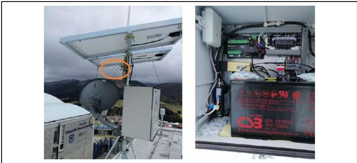
**Colegio Eduardo Umaña:** Se instalo y configuro un radio cnReach N500 el cual se ubicó en un gabinete disponible para este fin en el techo de una de las edificaciones del colegio; la antena se ubicó en la estructura que sostiene los paneles solares y el gabinete de equipos, se colocan los elementos necesarios para su funcionamiento como cable coaxial, protector de red, conectores, terminales y otros.
