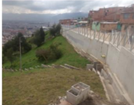
Después de la Intervención
