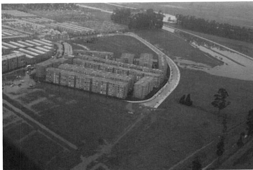
Foto 28. Zona afectada por la inundación en Kennedy
