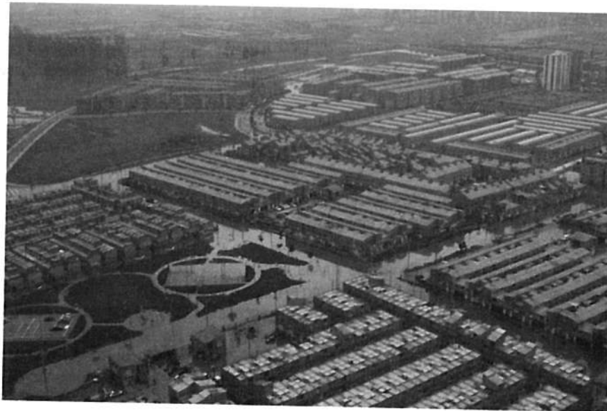
Foto 30. Zona afectada por la inundación en Kennedy
