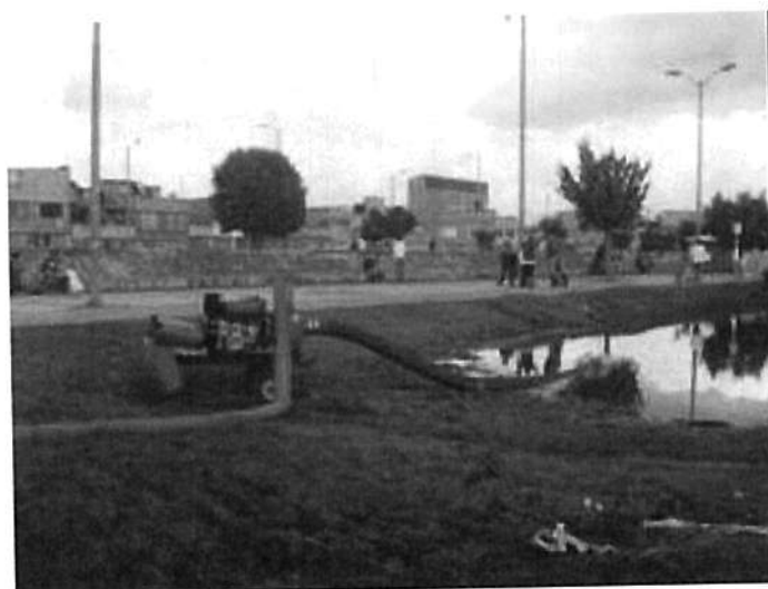
Foto 34. Bombeo localizado desde el conjunto residencial Alameda a un predio adyacente al Canal Cundinamarca
