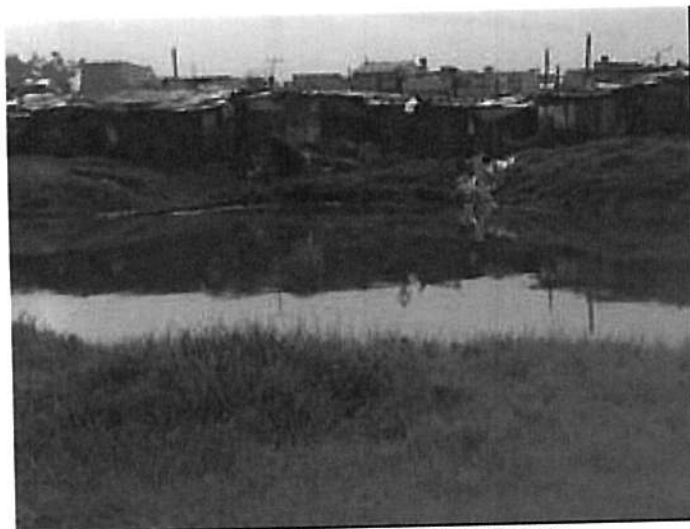
Foto 24. Borde libre del Canal Cundinamarca
