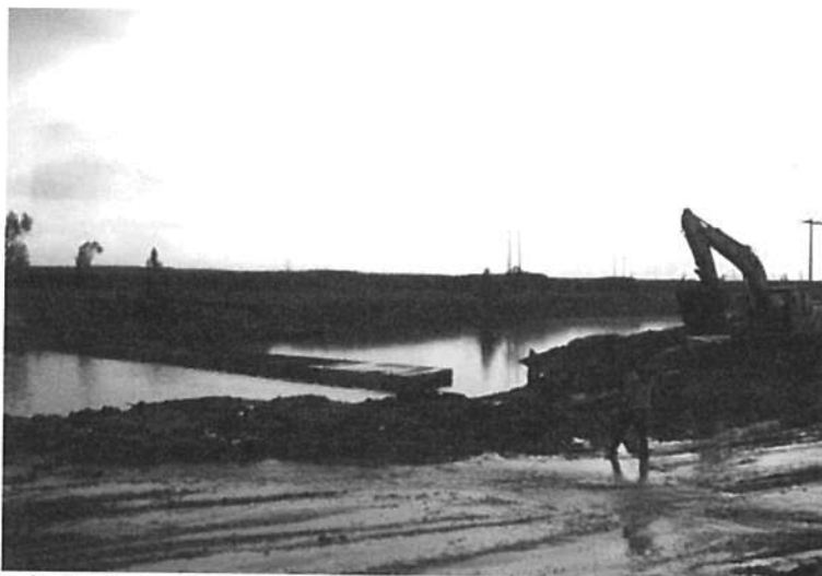
Foto 3. Construcción de la cámara norte del box coulvert que atraviesa el canal Cundinamarca.
