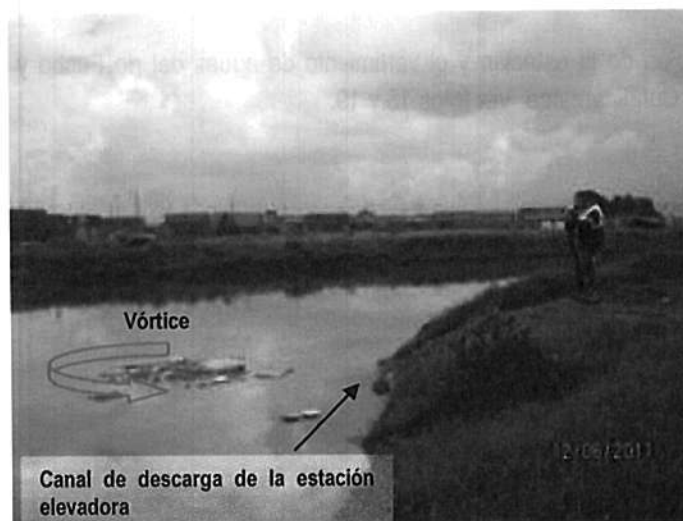
Foto 20. Vórtice de succión del agua desde el río Fucha a través del canal de descarga de la estación elevadora Fontibón
