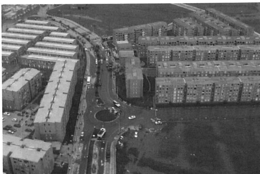
Foto 29. Zona afectada por la inundación en Kennedy
