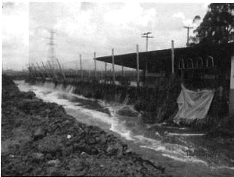
Foto 18. Inundación de la estación elevadora Fontibón y vertimiento al canal Cundinamarca a través del cerramiento
