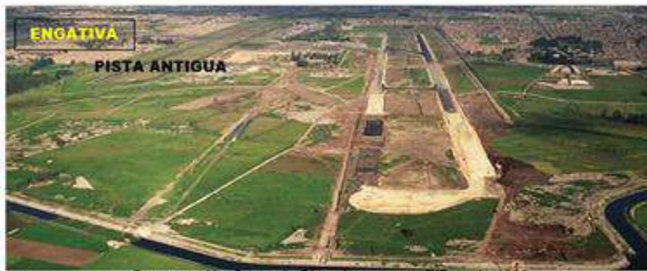
Construcción Segunda Pista Aeropuerto El Dorado 1998
