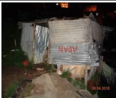
Foto No. 1. Vista frontal de la vivienda 1
