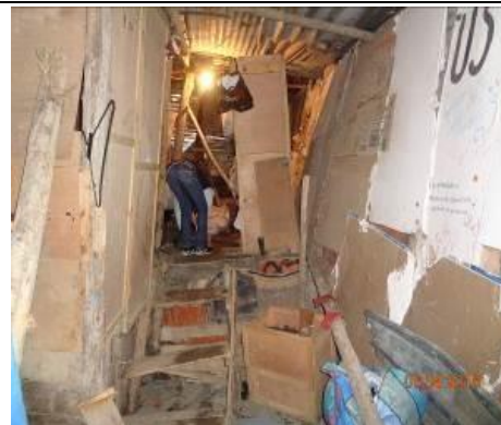
Foto No. 2. Vista interior de la vivienda 1
