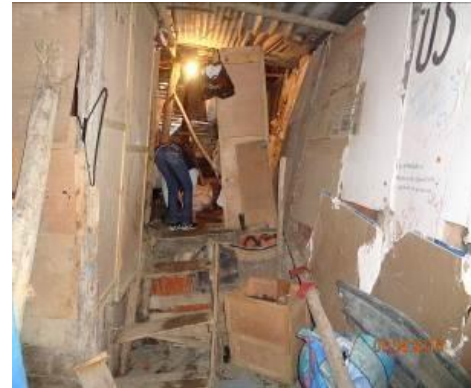
Foto No. 2. Vista interior de la vivienda 1
