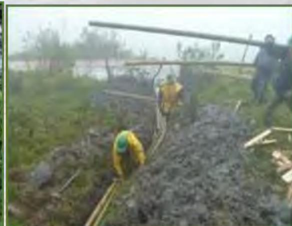
Ilustración 5. Evidencia del problema superior de la vía donde existía remoción en masa severa. Además, existían problemas de encharcamiento y saturación de los poros del terreno y colmatación del suelo. (A.L. Sumapaz, 2018)
