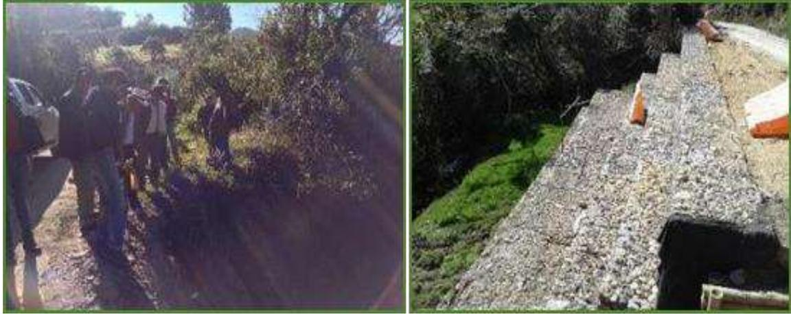
Ilustración 4. Evidencia las obras construidas, gaviones parte baja de la vía, dissipadores, terrazas, filtros y trinchos parte lateral y superior. (A.L. Sumapaz, 2018)
