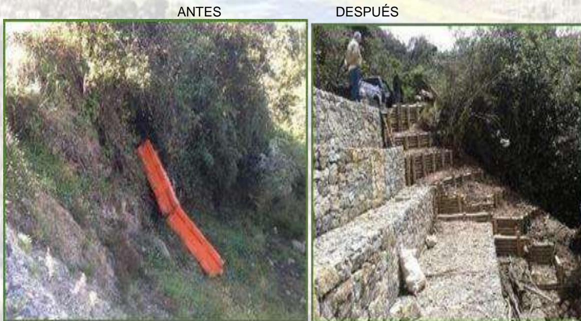
Ilustración 3. Evidencia del problema parte baja de la vía, pérdida de la bancada y remoción en masa, causada por el efecto del agua y gravedad. (A.L. Sumapaz, 2018)
