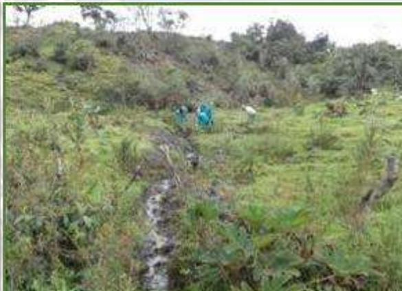
Ilustración 6. Evidencia las obras construidas. Zanjas de infiltración que conducen el agua al drenaje natural ayudándose con filtros, trinchos y dissipadores. (A.L. Sumapaz, 2018)
