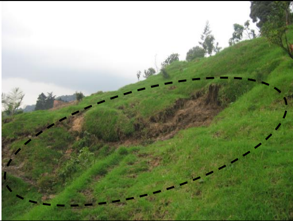
Vista del costado Sur del proceso de remoción en Masa evidenciado en el sector de la Avenida Circunvalar a la altura de la Calle 18.
