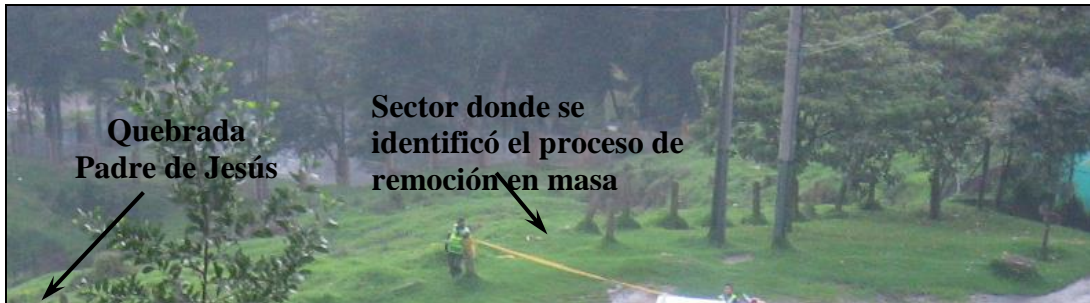
Vista general del predio de la Avenida Carrera 1 # 16 – 31, donde se identificó un proceso de remoción en masa de tipo complejo y que según la inspección visual se encuentra inactivo.
