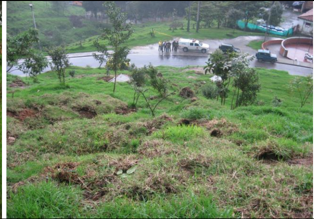
Vista desde el costado oriental, se observa la masa inestable sobre la ladera, que puede llegar a comprometer en su totalidad y en el corto plazo la transitabilidad de la totalidad de la Avenida Circunvalar, sentido Sur-Norte.
