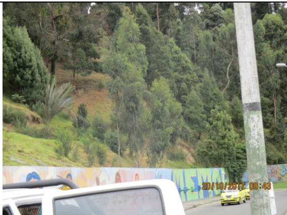
Canales de control de agua superficial y muro de contención.
