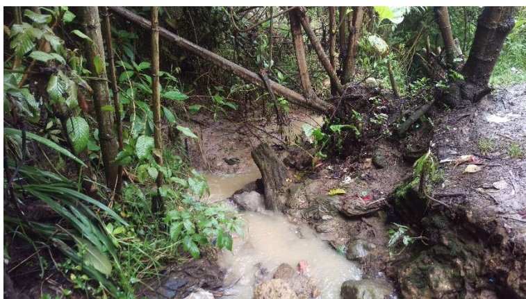
Árbol que perdió soporte y cae sobre el cauce de la quebrada. Se observa también desestabilización del talud.
