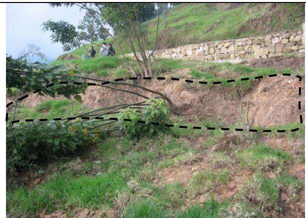
Se observa el escarpe al costado occidental del sendero peatonal de acceso a la facultad del Medio Ambiente de la Universidad Distrital Francisco José de caldas.
