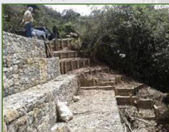
Ilustración 3. Evidencia del problema parte baja de la vía, pérdida de la bancada y remoción en masa, causada por el efecto del agua y gravedad. (A.L. Sumapaz, 2018)
