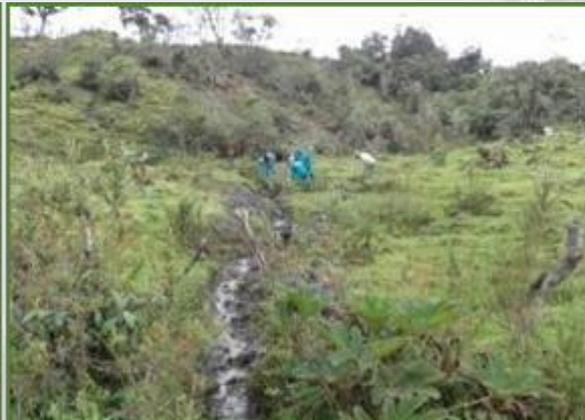
Ilustración 6. Evidencia las obras construidas. Zanjas de infiltración que conducen el agua al drenaje natural ayudándose con filtros, trinchos y dissipadores. (A.L. Sumapaz, 2018)
