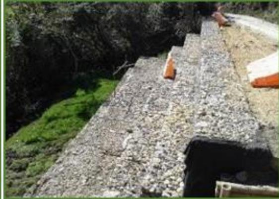
Ilustración 4. Evidencia las obras construidas, gaviones parte baja de la vía, dissipadores, terrazas, filtros y trinchos parte lateral y superior. (A.L. Sumapaz, 2018)
