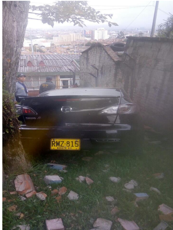
Colisión de muro e ingreso de vehículo al Centro de Desarrollo Comunitario - CDC de Lourdes. Fotografía de SDM, 2018.
