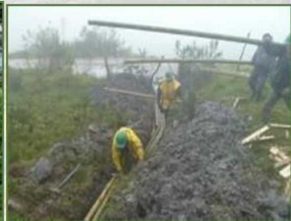
Ilustración 5. Evidencia del problema superior de la vía donde existía remoción en masa severa. Además, existían problemas de encharcamiento y saturación de los poros del terreno y colmatación del suelo. (A.L. Sumapaz, 2018)
