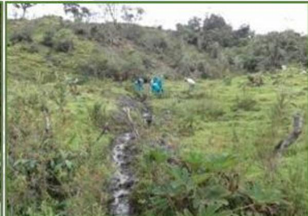
Ilustración 6. Evidencia las obras construidas. Zanjas de infiltración que conducen el agua al drenaje natural ayudándose con filtros, trinchos y disipadores. (A.L. Sumapaz, 2018)
