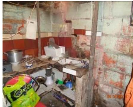
Foto No. 4. Grietas en muros perimetrales vivienda 2
