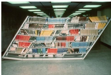
Fotografía 35. Evidencia de falla en el anclaje de elementos no estructurales
