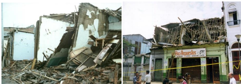
Fotografía 26. Daños severos en muros de bahareque
