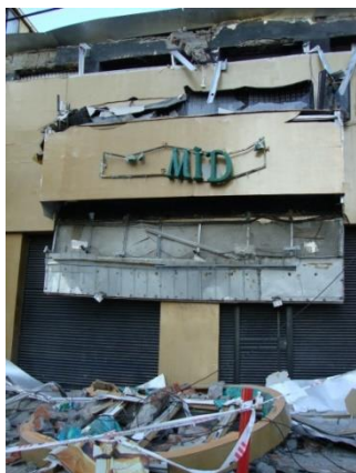
Fotografía 15. Evidencia de daños severos en acabados exteriores
