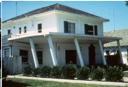
b. Daño severo
