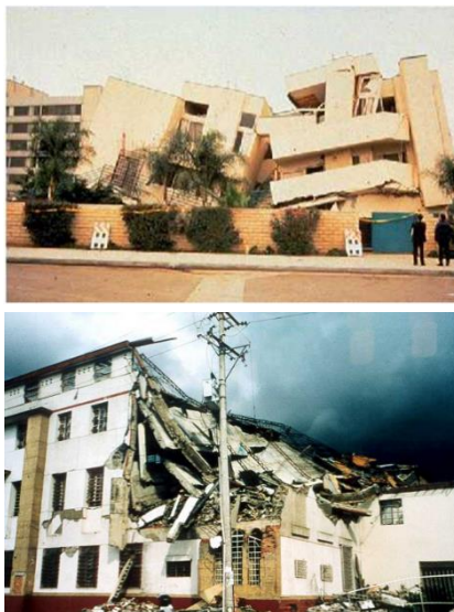
Fotografía 8. Inclinación de la edificación o de un entrepiso
