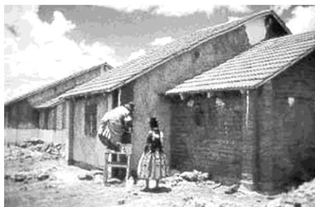
Fotografía 5. Edificación construida en tapia o adobe
