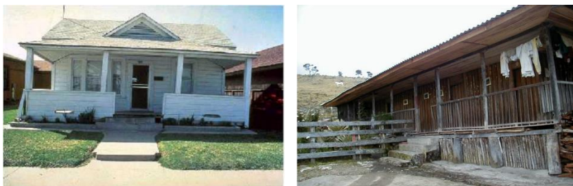
Fotografía 4. Edificaciones construidas en madera
