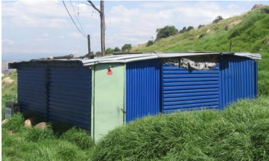
Fotografía 6. Edificación construida en material precario
