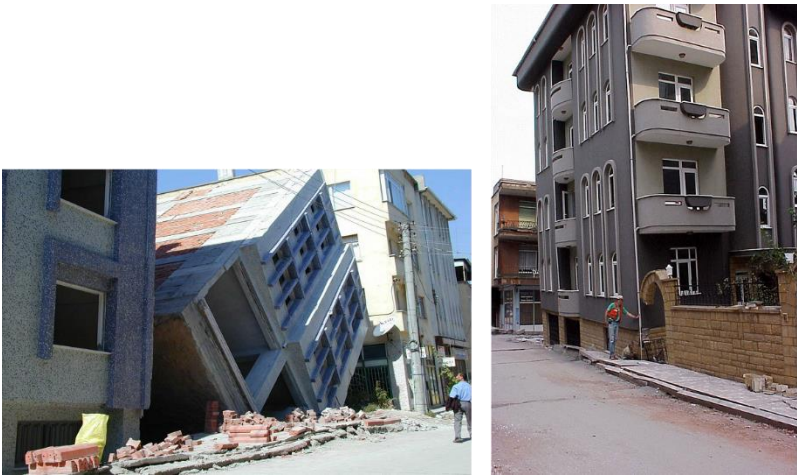
Fotografía 9. Fallas en el suelo de cimentación
