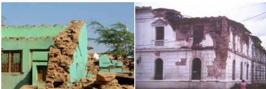
Fotografía 26. Daños severos en muros de bahareque
