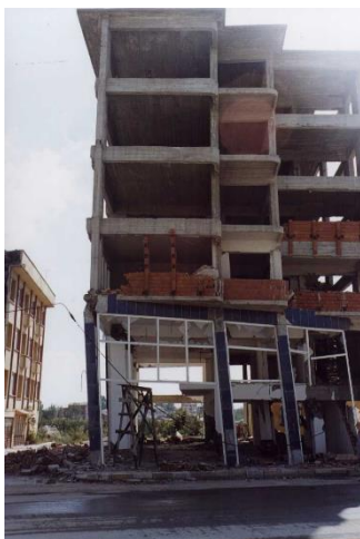
Fotografía 8. Inclinación de la edificación o de un entrepiso
