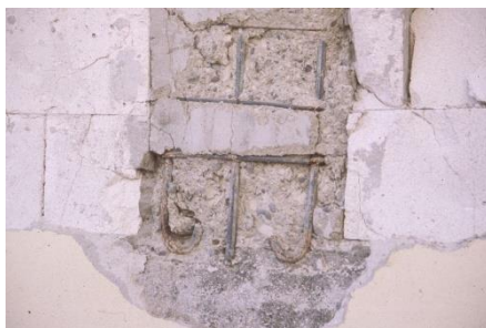
Fotografía 30. Ejemplos de mala calidad en la construcción
