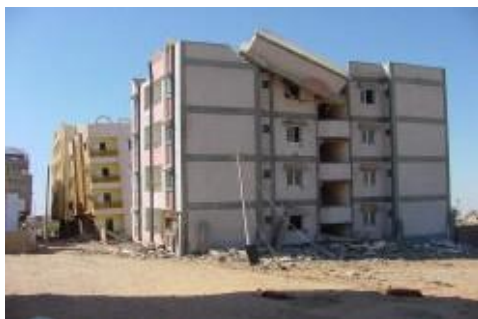
Fotografía 22. Daño severo en tanque
