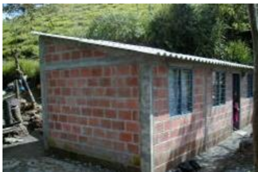
Fotografía 2. Edificación construida en mampostería confinada
